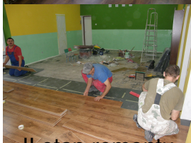
II etap remontu
